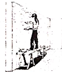
Luego, se llena el paño con la mezcla para grueso. La mezcla se tira con cuchara, en sucesivas capas para que no se caiga.
